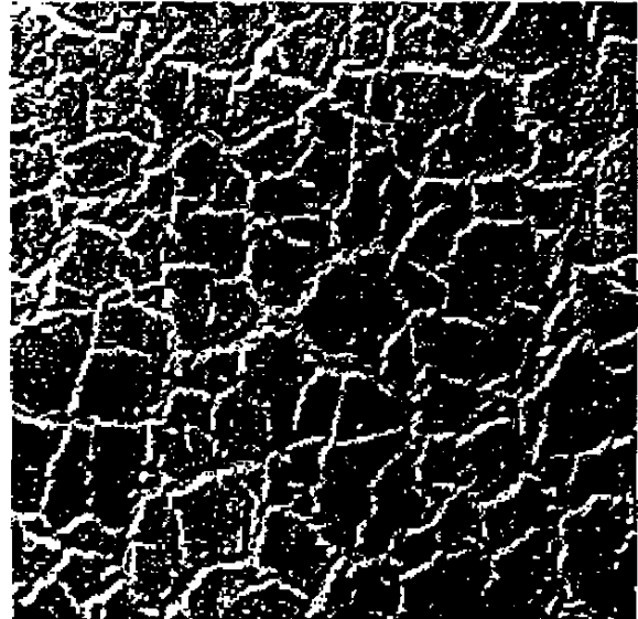
Рисунок 4 — Образование трещин лакокрасочного покрытия в виде «крокодиловой кожи»
