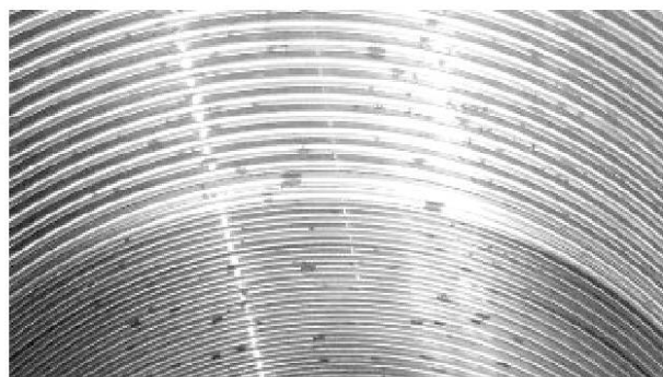
в) Следы коррозии на внутренней резьбе
