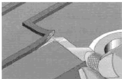
Рисунок 17 а – Нанесение эпоксидного состава под отслоившийся проводник
