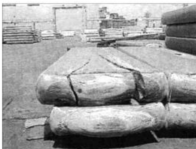
Рисунок А.8 — Трещина донная
