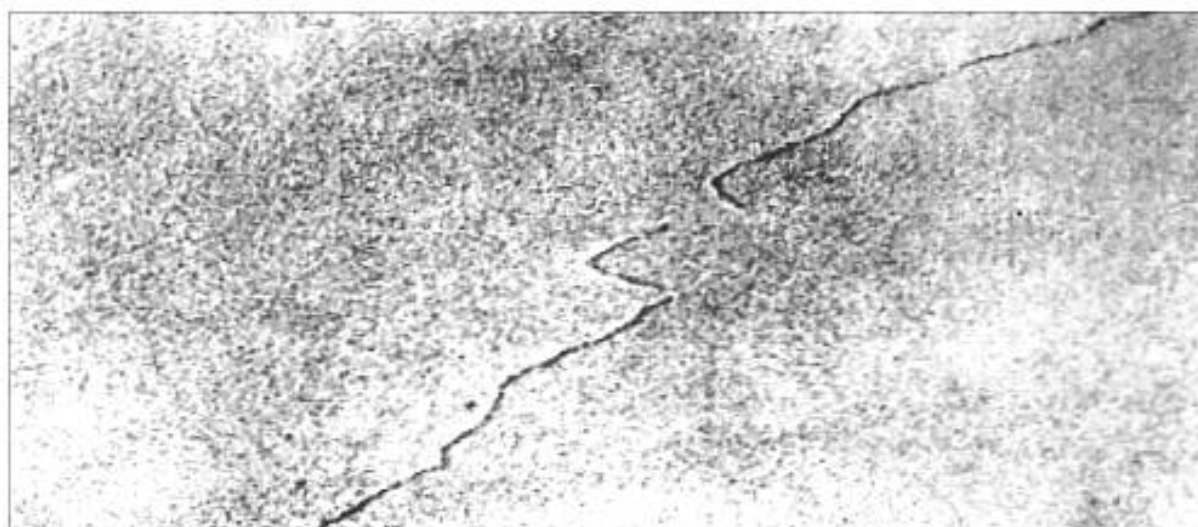
Рисунок А.79 — Раскатанная трещина
