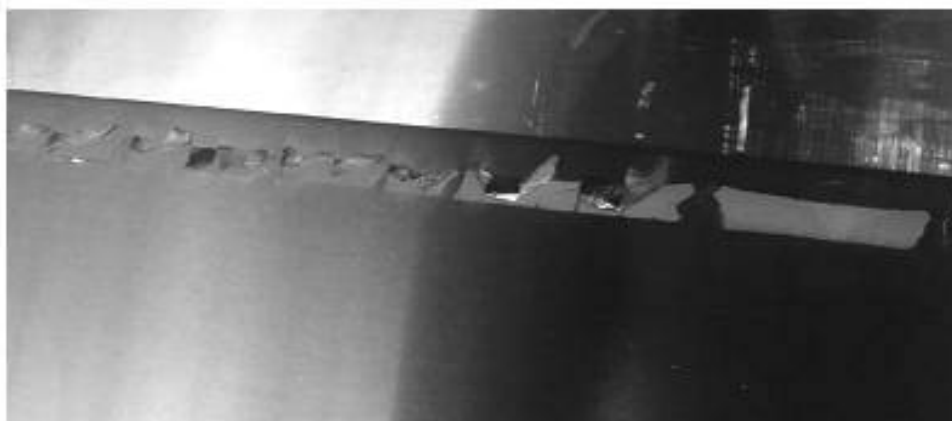
Рисунок А.25 — Отслоение
