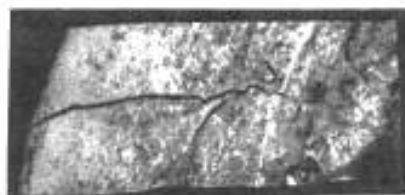
Рисунок А.26 — Трещины поверхностные
