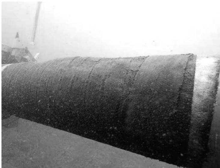
Рисунок А.3 — Общий вид бандаж из композитного материала
