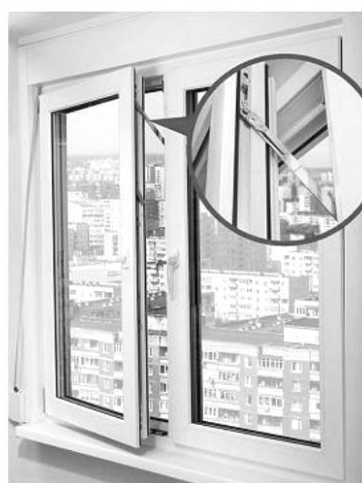
б – ограничитель поворотного (распашного) открывания, установленный в фурнитурный паз створки
