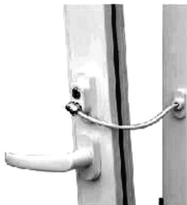
Рисунок Д.6 — Вариант ограничителя с тросом для фиксации поворотного (распашного) открывания створки
